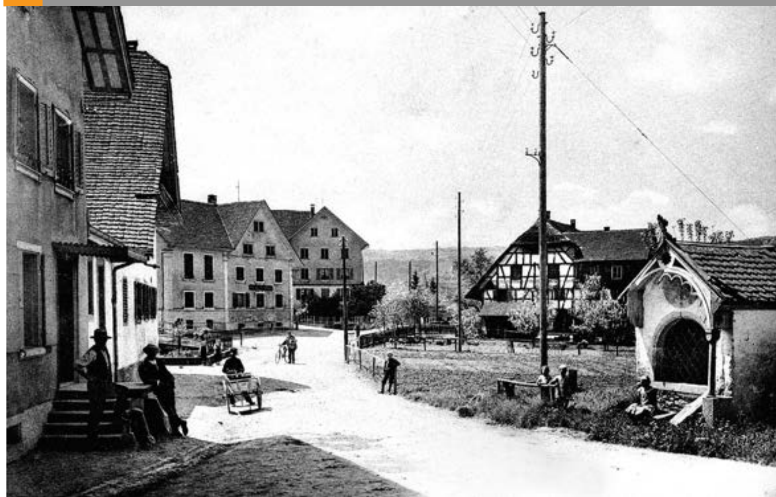
Rössliplatz um 1910. Markant, der hinter dem Rössli stehende Haulihof, der 1953 abgebrochen wurde.
